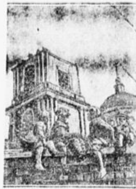
Церковь перестраивается под клуб.
