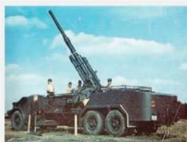
■ Для установки орудия на “гражданское” шасси для тяжелых грузовиков и автобусов специалистам фирмы VOMAG пришлось серьезно потрудиться. Получившийся в результате агрегат уже ничем не напоминал оригинальный Vomag 7 OR 660
