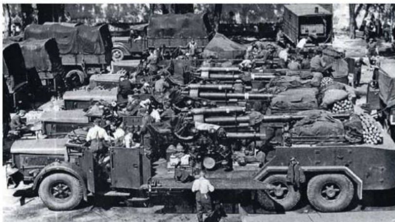
■ Для установки орудия на “гражданское” шасси для тяжелых грузовиков и автобусов специалистам фирмы VOMAG пришлось серьезно потрудиться. Получившийся в результате агрегат уже ничем не напоминал оригинальный Vomag 7 OR 660
