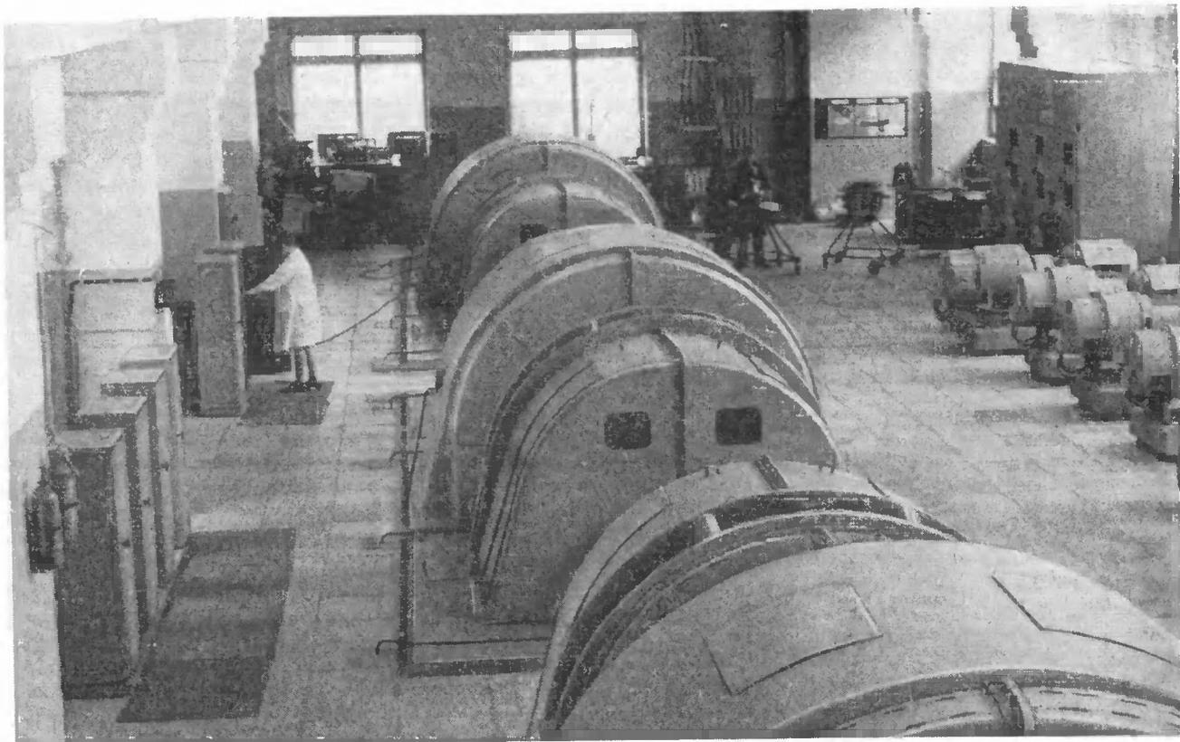
Рис. 4. Система питания магнитов. В эту систему входят 3 одинаковых блока, 2 из которых видны на снимке полностью, а третий, на переднем плане, — частично. Каждый блок состоит из двигателя переменного тока и двух одинаковых генераторов по 1,5 Мвт при напряжении 250 в. Для питания магнита на 100 кэ достаточно одного блока. Для получения 200 кэ необходимы все три. В правой части снимка видны главные выключатели и генераторы возбуждения. С лева — шкафы электронной системы управления.
