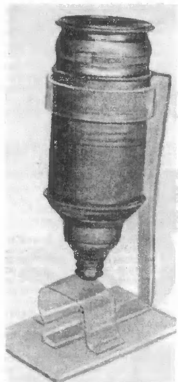
Тубус четырехлинзового неахроматического микроскопа, сделанный (предположительно) И. П. Кулибным.
