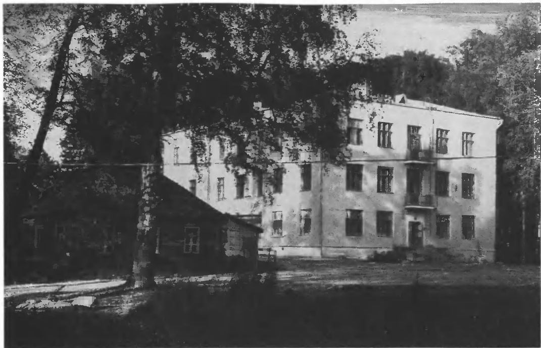
Главный лабораторный корпус.
