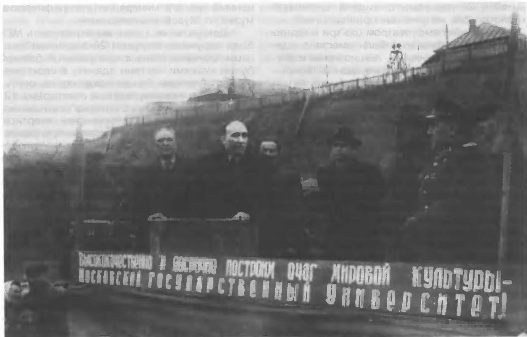
Митинг в котловане нового здания университета. 1949 г.
