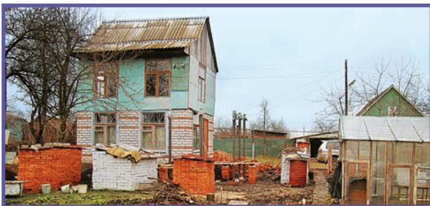
Доставшийся нам дом не устраивал ни внешним видом, ни удобствами, да и участок требовал серьезных работ по благоустройству
