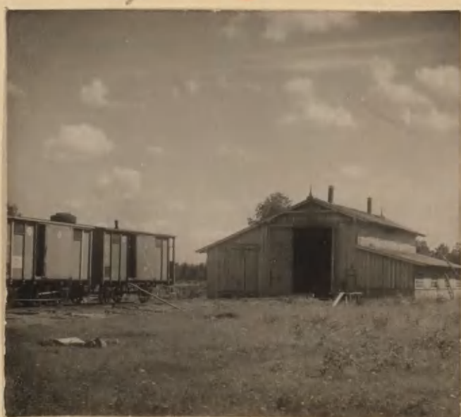
63 P87-2064 (кап. 55) Ж. д. депо на станции Каннесенга
