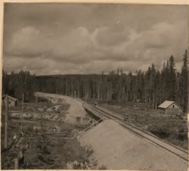
93 1987-2093 (кайт. 81) Ж.д. мосты через речку Литозерку
