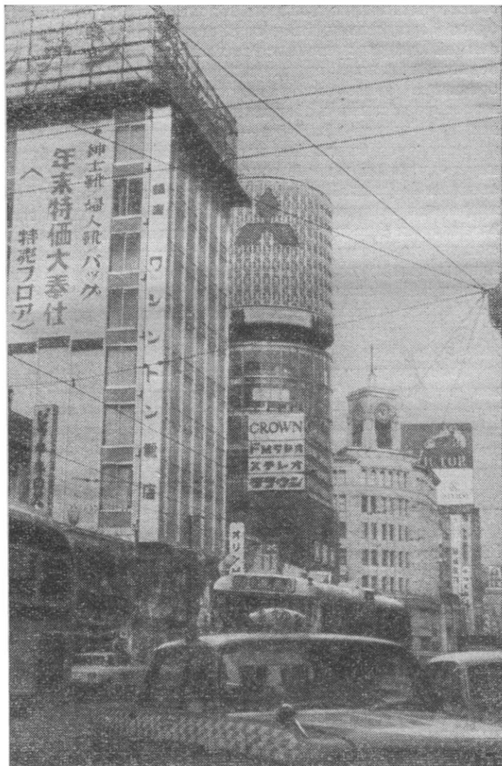
Новые здания на Гиндзе
