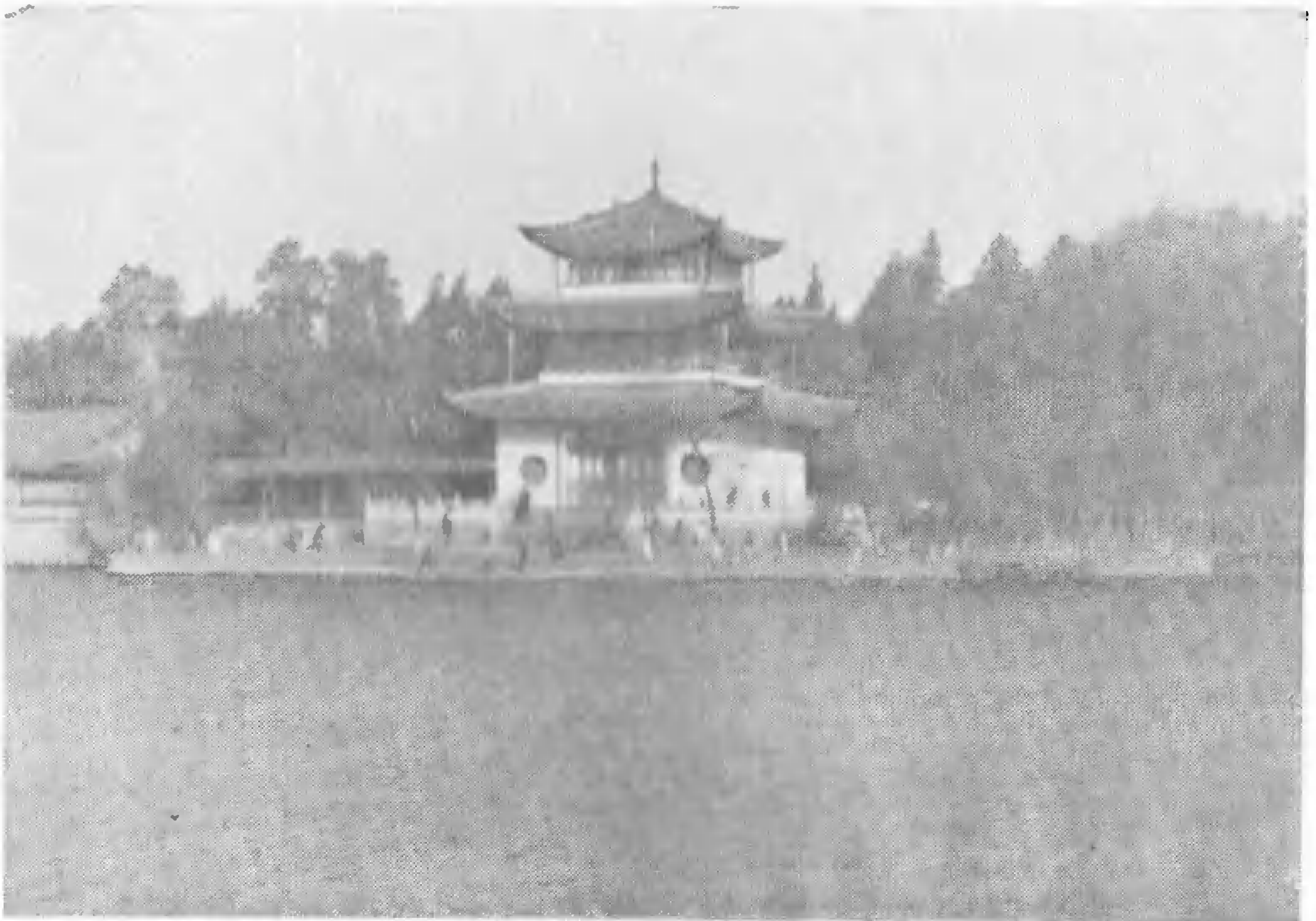
Рис. 24. Башня большого обзора
