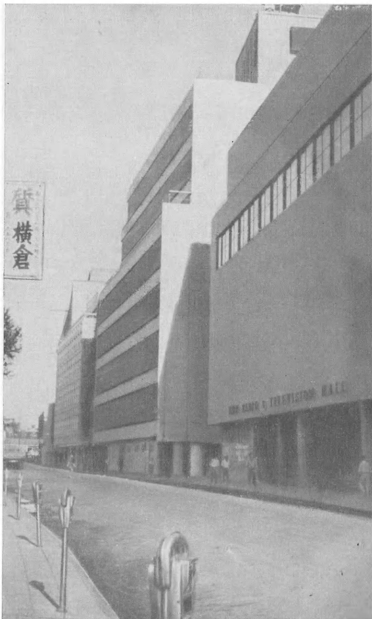
Современные японские здания — алюминий, стеклопластик, бетон
