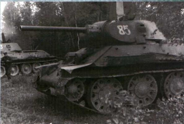
**Слева:** Танк Т-34 производства СТЗ выпуска конца 1941 года с цельнометаллическими опорными катками и необрезиненным направляющим колесом.
