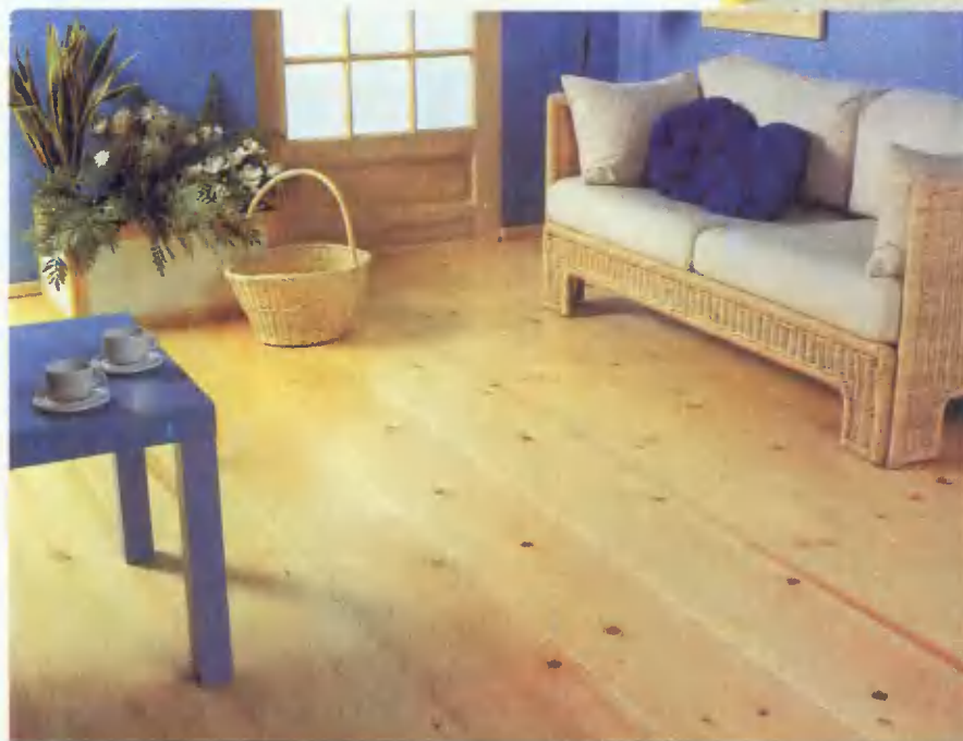
Паркетные доски, уложенные по основе из шпунтованных подкладочных ДСП.
