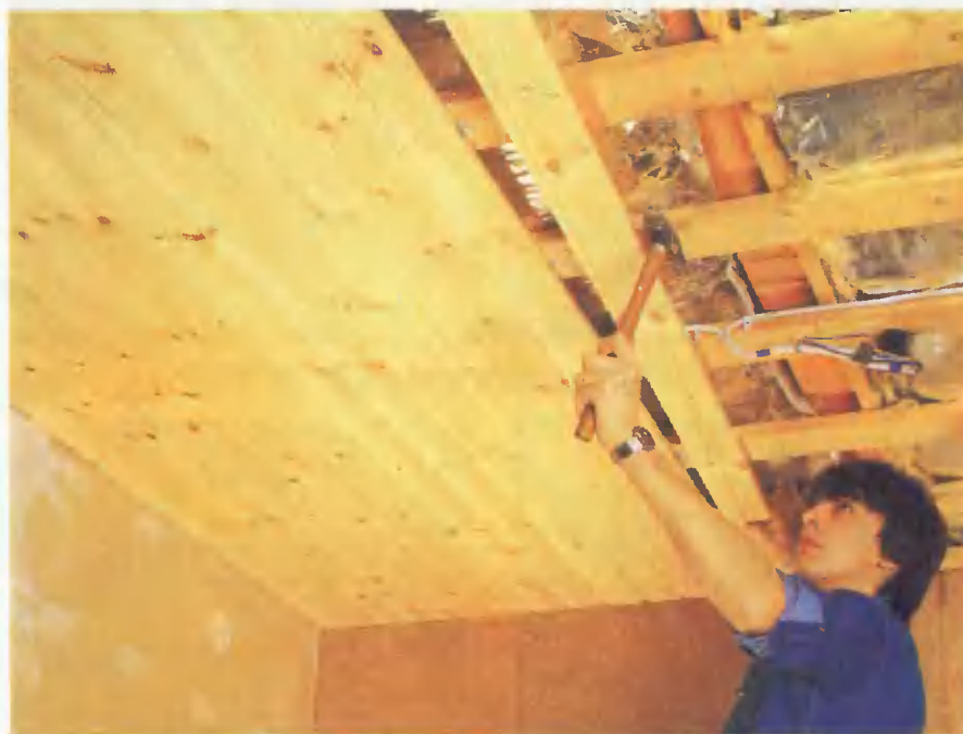
Несущей для дощатого потолка является устроенная из достаточно мощных брусков конструкция обрешетки.
