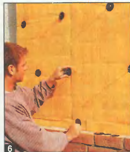
6 На каждый теплоизоляционный мат должно приходиться 5-6 точек крепления. Маты насаживают на анкеры и крепят специальными шайбами встык друг к другу без зазоров.
