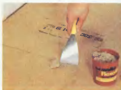
Стыки между подкладочными плитами зашпаклевывают.
