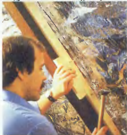
Рейка, прибитая к стропильной ноге, ...
