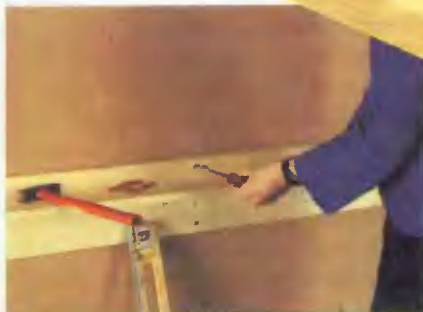
Крепят угловой профиль к стене при помощи дюбелей и шурупов.
