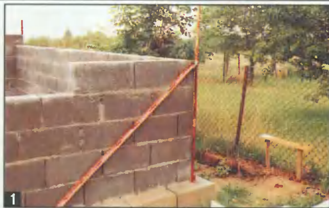
1 В начале кладки угловой репер закреплен на выступающей части цоколя фундамента.
