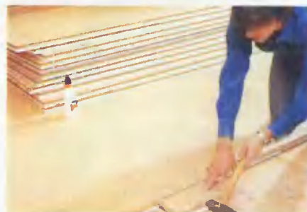
Соединение подкладочных плит в шпунт и гребень.
