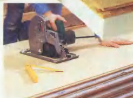
Раскрой шпунтованных ДСП производят ручной дисковой пилой.
