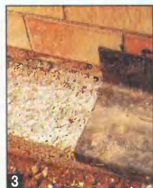
Под облицовочную стенку делают дополнительный ленточный фундамент. На снимке хорошо видна гидроизоляция, защищающая кладку облицовочной стены от отсыревания.
