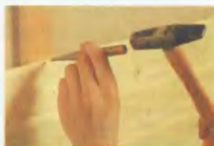
При обшивке стен вагонкой шляпки гвоздей следует утопить в древесину.
