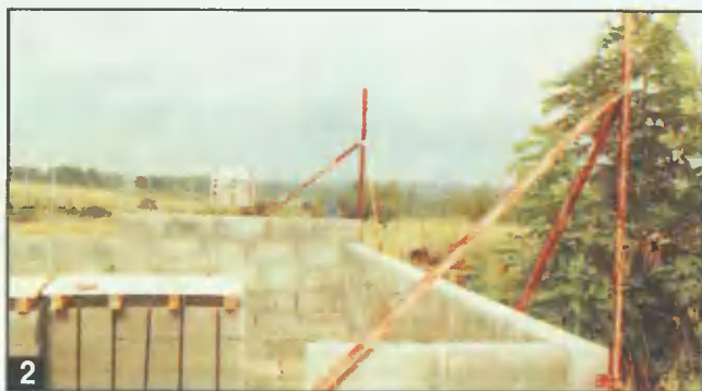
2 Положение реперных стоек при продолжении кладки стен.
