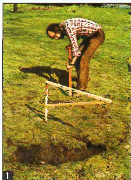
1 На выбранной для сооружения бассейна площадке размечают контуры его чаши и отрывают котлован глубиной примерно 40 см.
