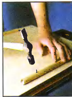
Рис. 8. Монтаж штепсельной планки.
