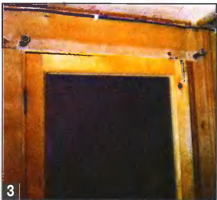
Ставня изнутри крепится гайками, наворачиваемыми на приваренные к раме болты М16.
