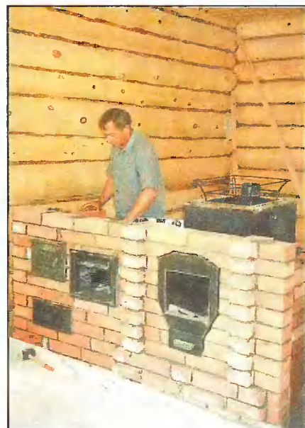
Момент строительства отопительного комплекса с металлической печью-каменкой (за работой — Н.Сердюк).
