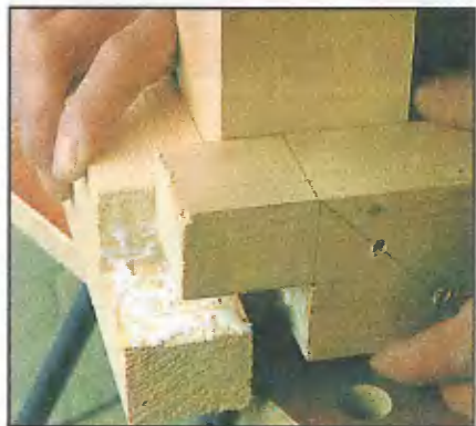
Бруски обвязки, концы которых запиливают вполдерева, соединяют друг с другом и со стойками на клею и шурупах.
