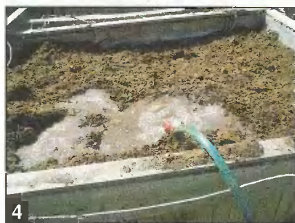
4 Поверх плёнки насыпаю слой заранее подготовленного плодородного грунта толщиной примерно 25 см.
