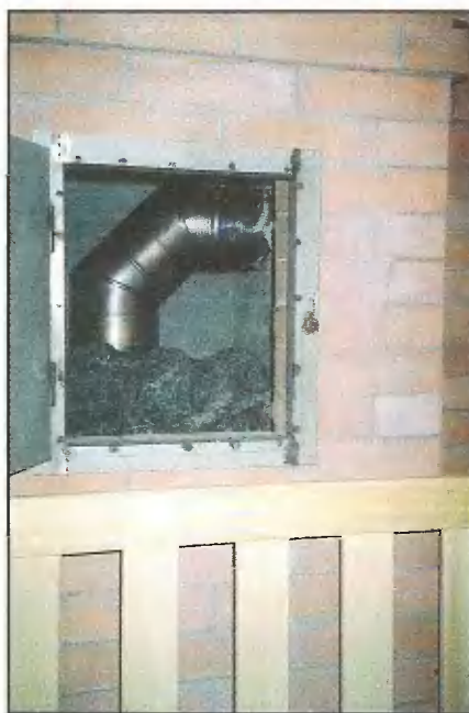
Окно каменной засыпки с дверцей.
