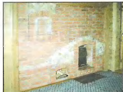
Металлическая банная печь в кирпичной облицовке. Вид из комнаты отдыха.
