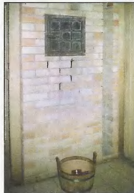
Печи с каменкой «на проход» (камни внутри печи обогрываются непосредственно дымовыми газами). Вид из парильного отделения.
