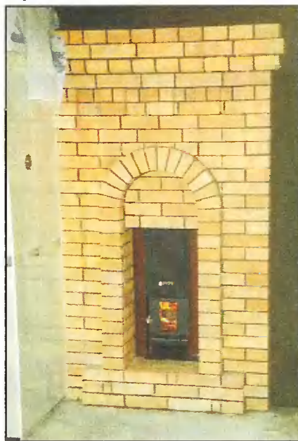
Другая разновидность металлической печи и иное оформление. Кладка — из шамотного кирпича.
