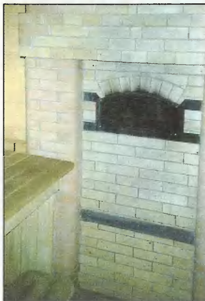
Печи с каменкой «на проход» (камни внутри печи обогрываются непосредственно дымовыми газами). Вид из парильного отделения.
