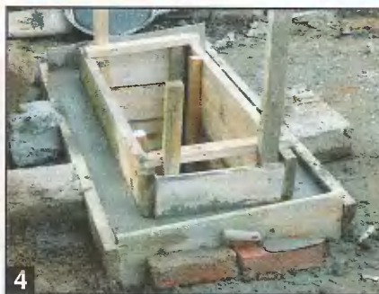
4 Бетонирование стенок приямка.
