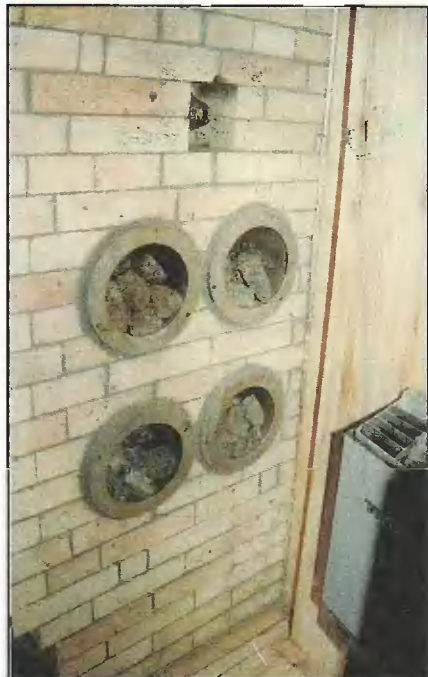
Печь-каменка с духовками в виде стальных труб Ø200 мм (автор А.Заболотный).
