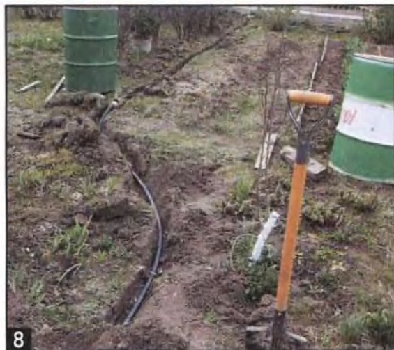
Пластиковые трубы летнего водопровода уложены в неглубокие траншеи, ...
