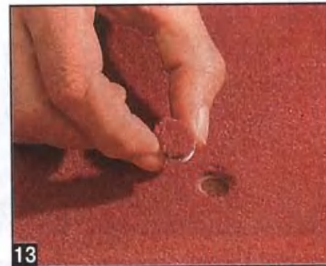
13 Смазав заплату клеем и совместив направление ворса, вставляют заплату в отверстие покрытия.
