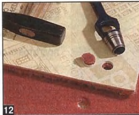
12 Используя деревянную подкладку, тем же пробойником из куска покрытия вырезают заплату-вставку.
