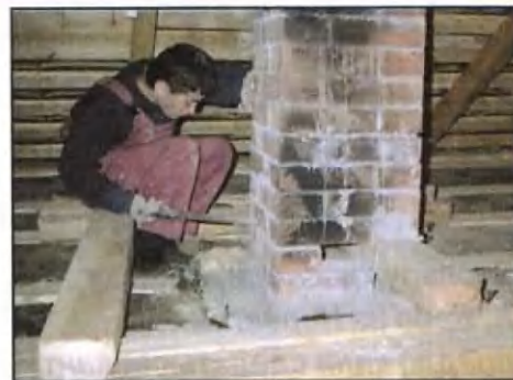
С одной стороны труба опирается на брус, можно расчищать швы с другой стороны.
