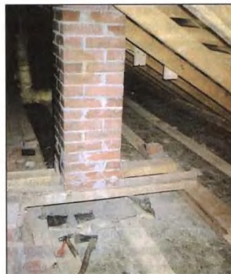
Труба в подвешенном положении опирается только на два бруса.
