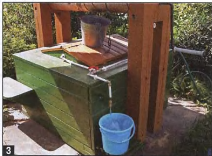
Соединение водопровода со скважиной выполнено гибким шлангом.
