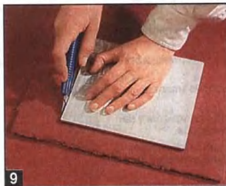
9 Уложив заплату на покрытие, прорезают ковровым ножом сразу оба слоя по шаблону.
