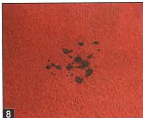
8 Заплата на повреждённом месте должна располагаться с совмещением направления ворса.
