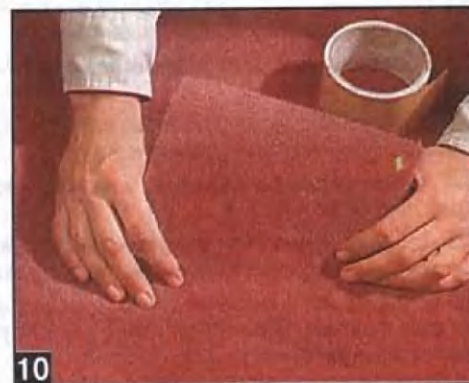
10 Зачистив кромки заплата, наносят слой клея, подгоняют заплату и приклеивают к основанию.
