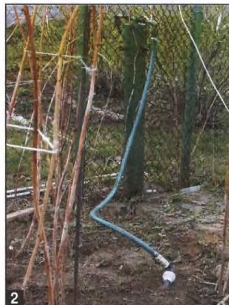
Соединение водопровода со скважиной выполнено гибким шлангом.
