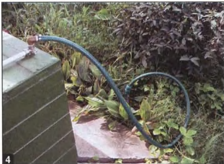
Точка отбора воды с быстротъёмным переходником и запорным шаровым краном.
