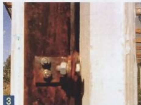
Крепление отдельных сваренных из уголков четырёх рам в единую конструкцию с помощью специальных элементов и болтов оказалось вполне надёжным.
