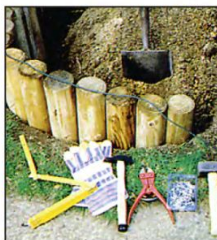
Колышки располагают дугобразно вплотную друг к другу и скрепляют проволокой в пластиковой оболочке. Проволоку фиксируют скобками.
