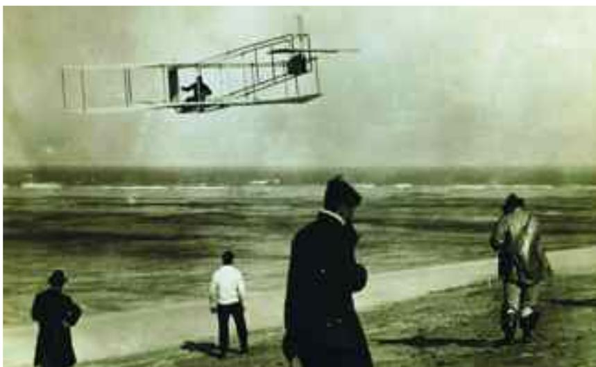
Эластичные крылья самолета братьев Райт создавали дополнительную подъемную силу и стабилизировали его по крену. Эта технология использовалась при невысокой скорости летательного аппарата. Новые скоростные режимы потребовали увеличения жесткости крыла.
