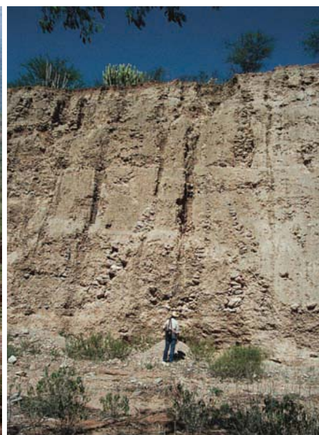
Плотина культуры Пуррон (на фото слева) около города Пуэбла в Мексике считается крупнейшим на американском континенте гидротехническим объектом доколониального периода. Строительство началось в 750 г. до н.э. и продолжалось с перерывами приблизительно до 1150 г., когда плотина достигла высоты в 25 м и протянулась на 400 м в длину. Человек ростом в 180 см выглядит карликом на фоне южного склона сооружения (фото справа)
