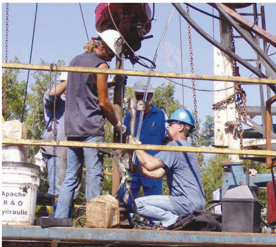
Похоронная команда: диоксид углерода в состоянии сверхкритической жидкости закачивается под землю на тестовом объекте Frio Formation в Техасе
