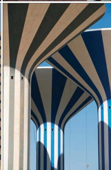
Формы обманчивы. Практически все резервуары имеют цилиндрическую форму для равномерного распределения веса воды между опорами, но в эстетических целях они могут быть скрыты за фасадами. На снимках по часовой стрелке, начиная с левого верхнего: Форкальке (Франция), Нью-Йорк, Кувейт, Гонолулу (шт. Гавайи)
