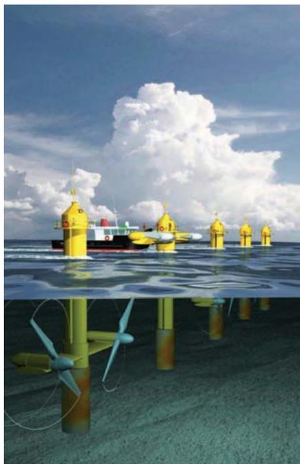
Приливная электростанция фирмы *Marine Current Turbines* состоит из нескольких подводных турбин. Винты диаметром 20 м вращаются под действием приливных течений и могут быть подняты на поверхность для техобслуживания
