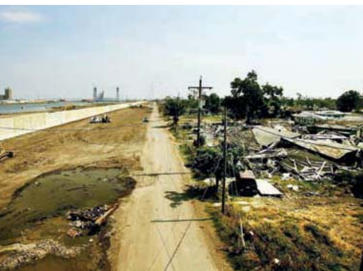
Новые дамбы для защиты от паводков возведены вдоль Промышленного канала, где через огромную брешь произошло затопление Девятого Нижнего района
