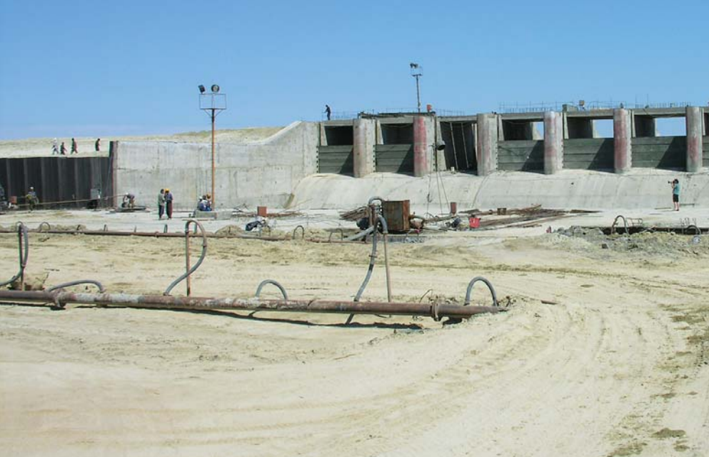
13-КИЛОМЕТРОВАЯ ДАМБА И ПЛОТИНА С ГИДРОТЕХНИЧЕСКИМ ЗАТВОРОМ (вверху), построенные Казахстаном в 2005 г., спасли Малый Арал, прекратив отток воды по пересыхающим, ведущим в никуда каналам. С тех пор наблюдается повышение уровня воды и рост рыбных популяций (внизу). Гидротехнический затвор, законченный в ноябре того же года, позволяет пропускать лишнюю воду для регулирования уровня водоема. Уже к следующему лету вода в Малом Арале поднялась на 2 м
