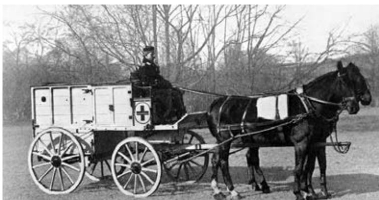
Германская передвижная рентгеновская установка, применявшаяся военными медиками в ходе Первой мировой войны, 1915 г.
