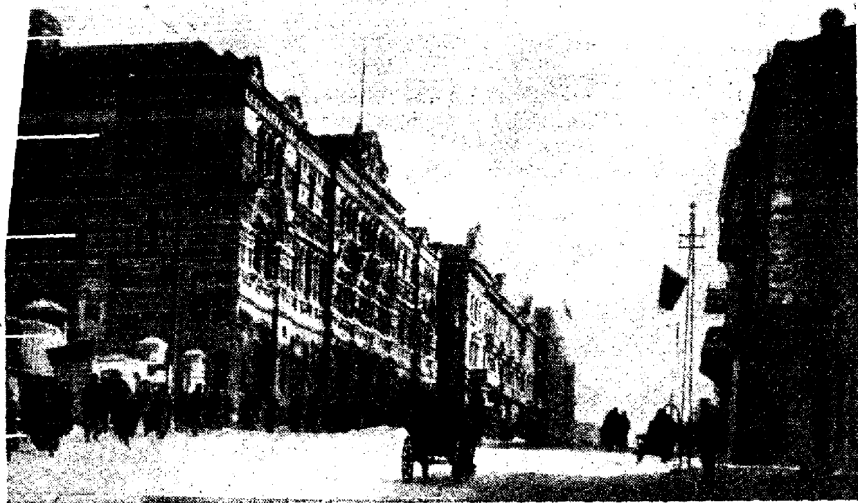
Здание главного почтамта во Владивостоке.
