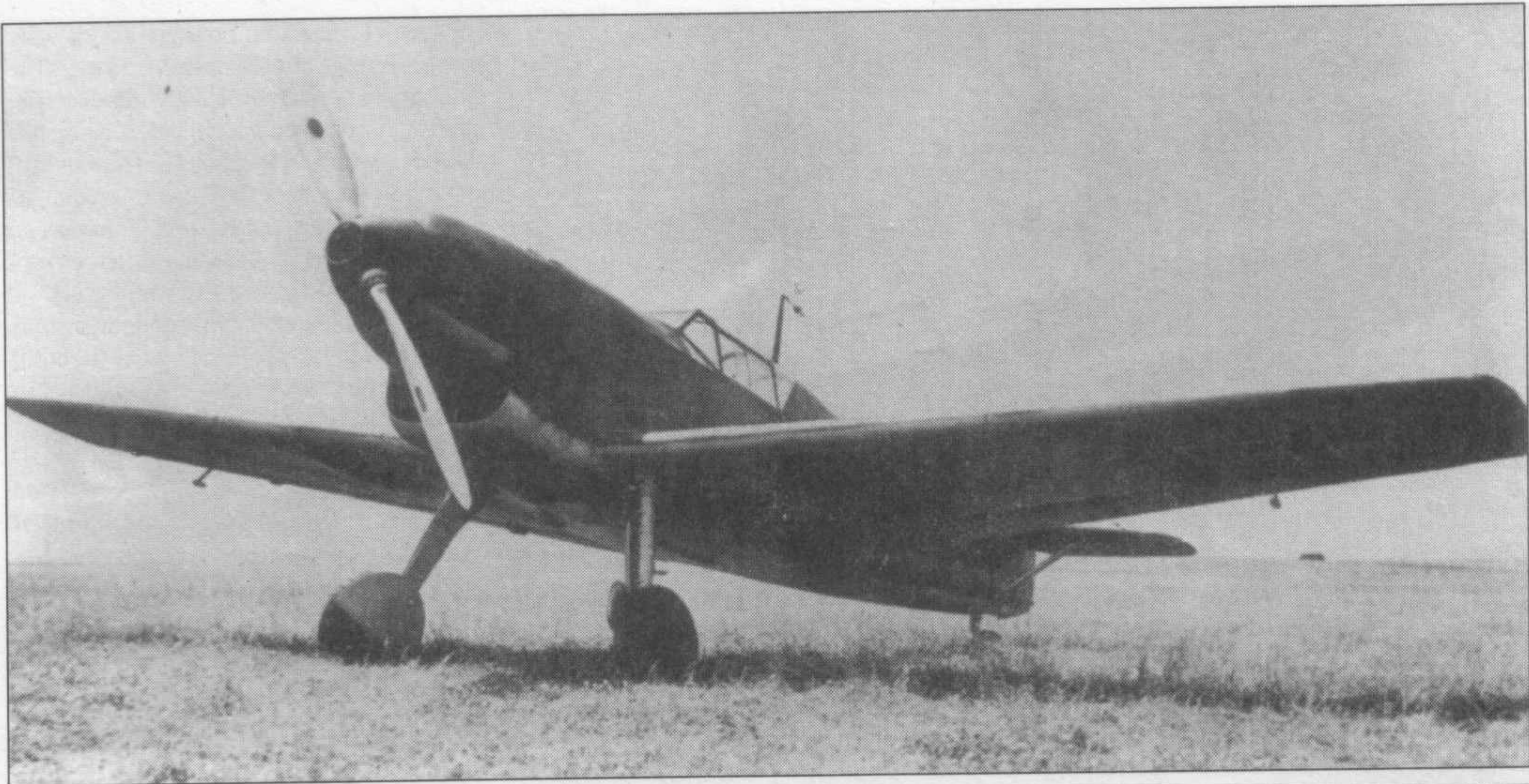
Еще два сравнительных снимка: «Берта» и «Дора» анфас. Вверху тот же Me 109B. Внизу Me 109D с опознавательными знаками, характерными для 1940 года. Учитывая старый камуфляж, можно заключить, что снимок сделан в октябре-ноябре 1939 года. На радиаторе видна нетипичная граница раздела верхнего (70/71) и нижнего (65) камуфляжа. Обратите внимание на выхлопные патрубки, характерные для самолетов с двигателем Jumo, выпущенных в 1938 году.
