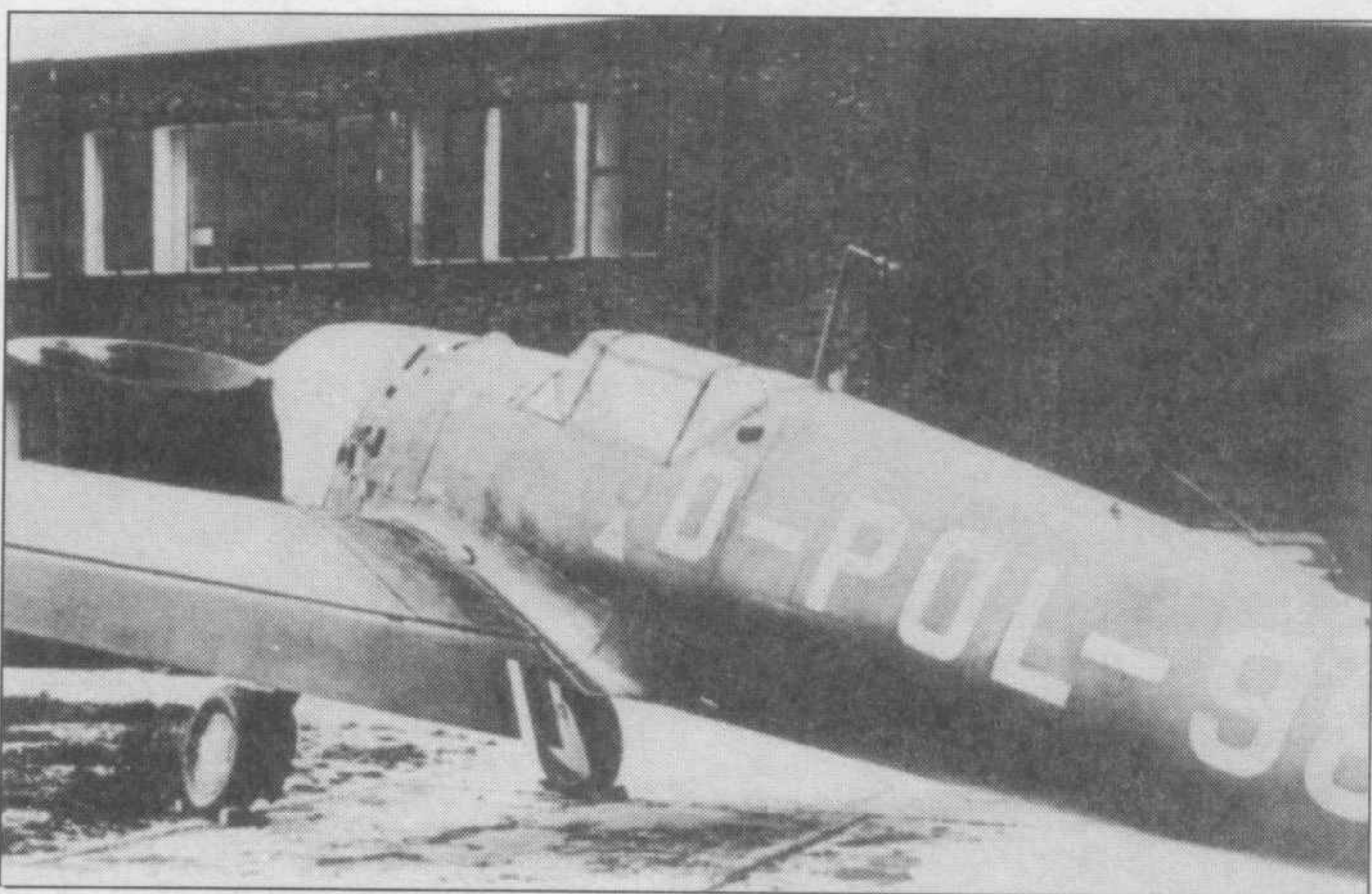
Кабина Me 109D крупным планом. Видны детали, в том числе щель между крышкой фонаря и фюзеляжем. За кабиной видны отверстия для зарядки кислородного баллона и аккумулятора. Ниже: Me 109B в окраске и с регистрацией немецкой полиции.
