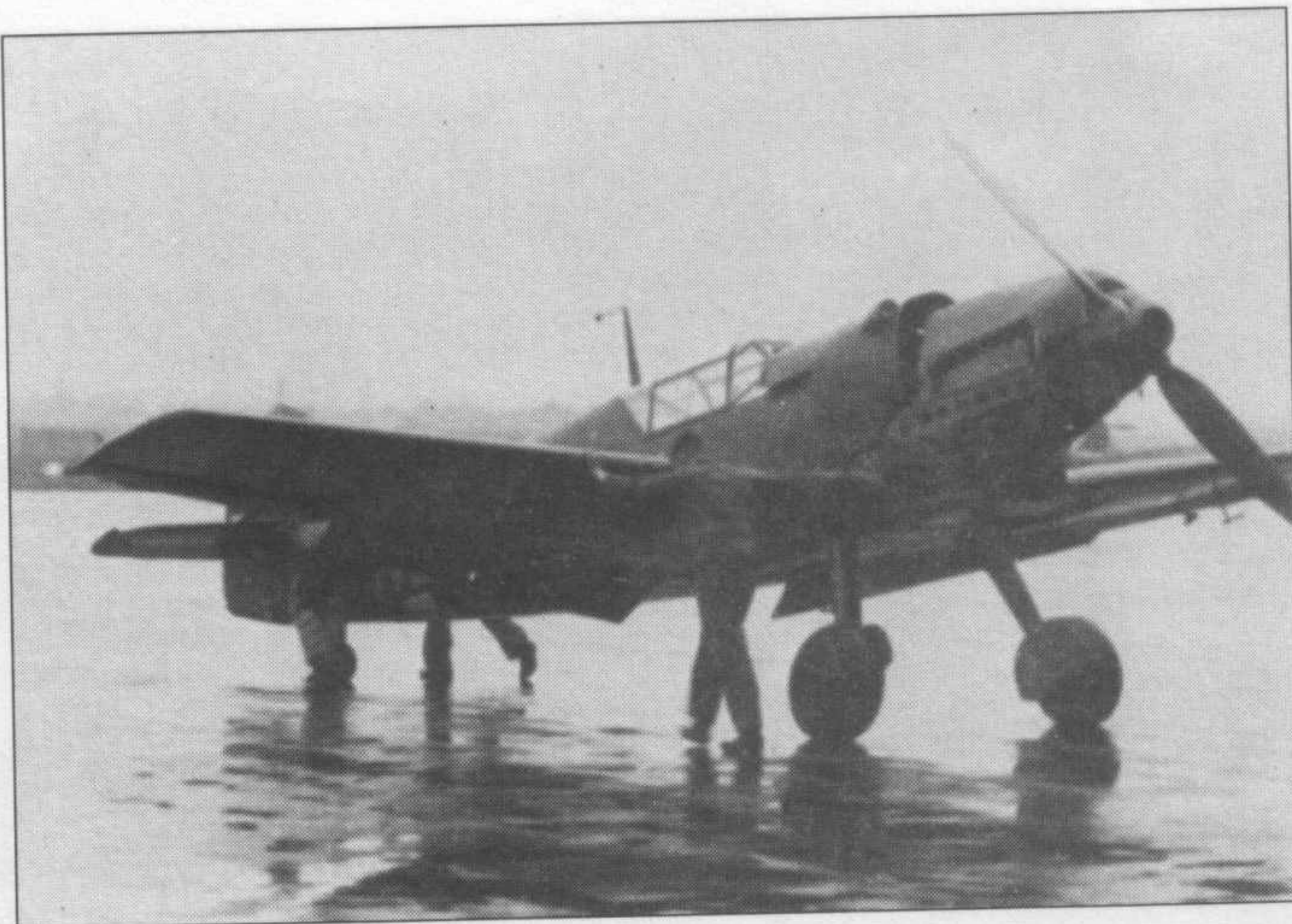
Новый Me 109B-2, оснащенный винтом с изменяемым шагом. Вентиляционные отверстия для пулеметов отсутствуют. Машина окрашена по стандартной схеме: сверху черно-зеленый (RLM 70) и темно-зеленый (RLM 71), а светло-голубой (RLM 65) снизу. Первоначально в люфтваффе много внимания уделяли маскировке самолетов на земле, чем и объясняется темный камуфляж, подходящий для европейских лесов.
