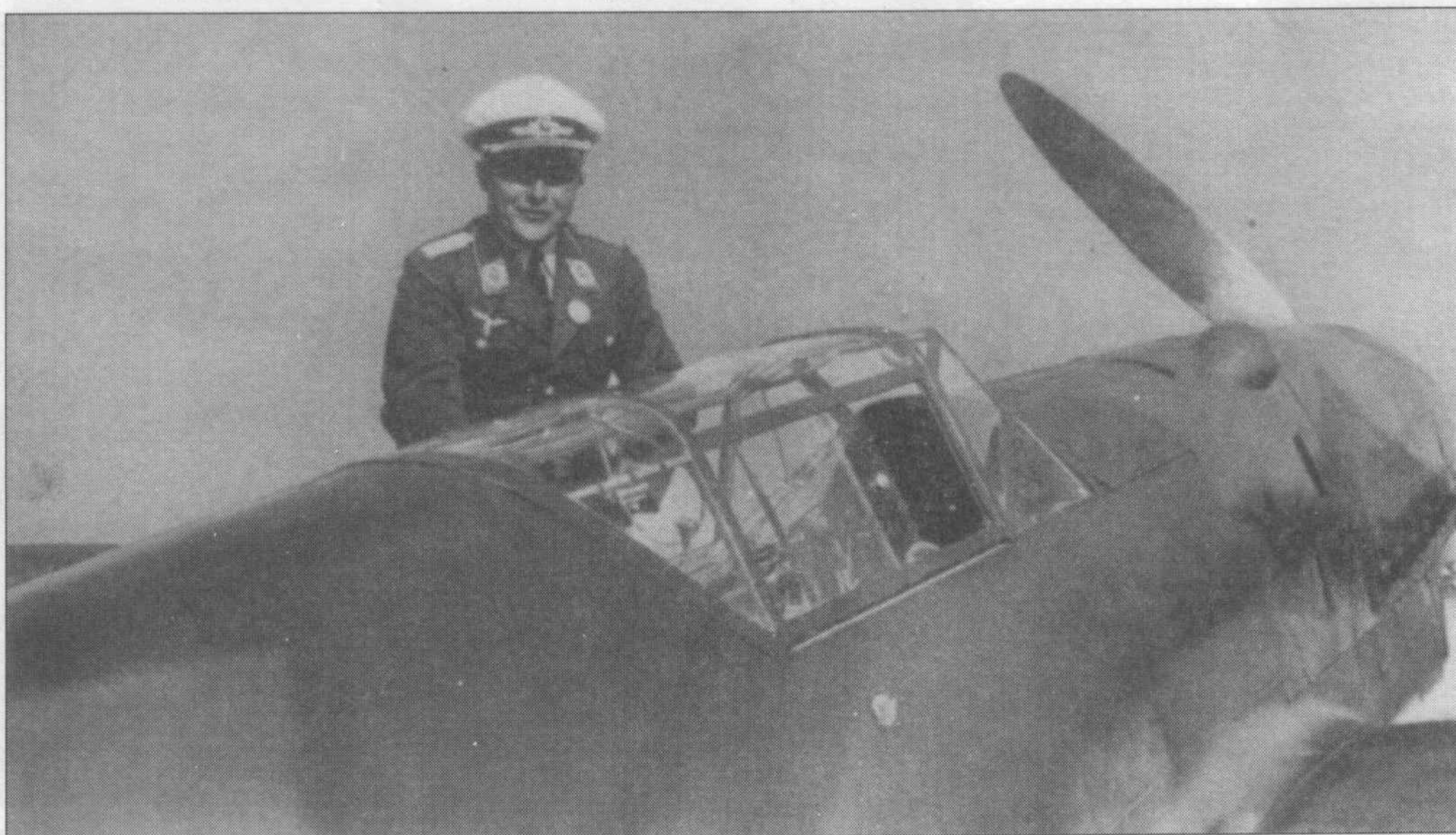
Франке у Me 109V10 (W.Nr. 1010) в Цюрихе. Видны отверстия для зарядки кислородного баллона и аккумулятора под фонарем кабины.
