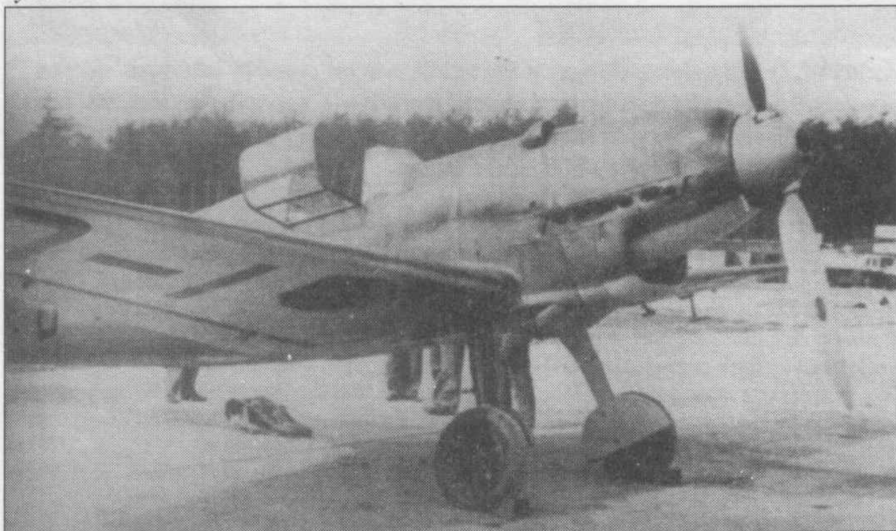
Два снимка Me 109B-0 (D-IEKS), сделанные зимой 1936/37 г.г. на заводском аэродроме в Аугсбурге. Самолет имеет ряд особенностей, характерных для серии B-0: отсутствуют пулеметы и радиостанция, укорочены предкрылки, маслорадиатор под левым крылом. Обтекатель втулки винта, похоже, выкрашен в желтый цвет.
