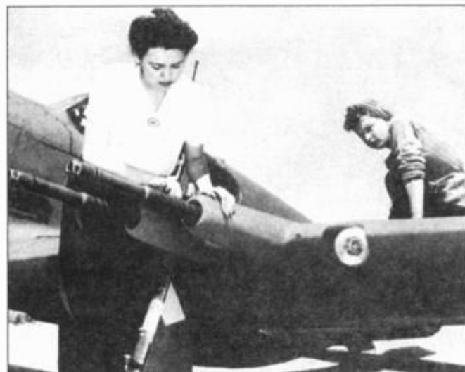
Пушки М-2 калибра 20 мм, установленные в крыле P-51.
