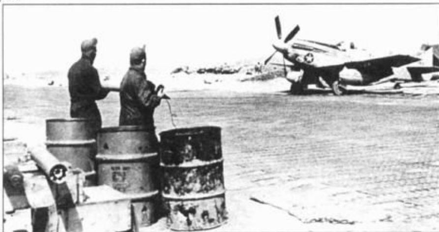
Механики готовят пятидюймовые ракеты для стоящего на заднем плане F-51D из 87th FBS. На капоте самолета звезда - эмблема Техасской воздушной гвардии.
