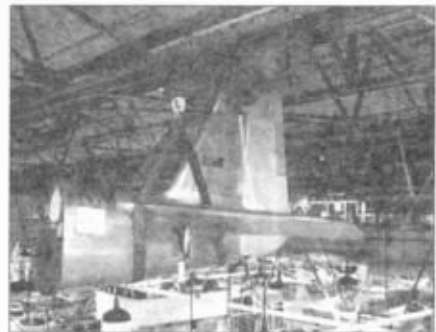
Переноска хвостовой секции P-51B для установки на самолет.
