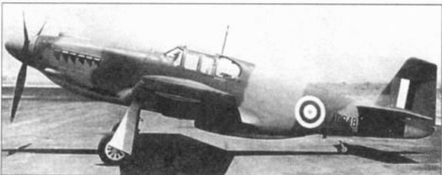
Четвертый серийный «Мустанг I» (AG348). Самолет еще имеет укороченный воздухозаборник карбюратора. После испытаний в Боском-Даун было решено вывести воздухозаборник сразу за винтом. Снимок сделан еще в Штатах.
