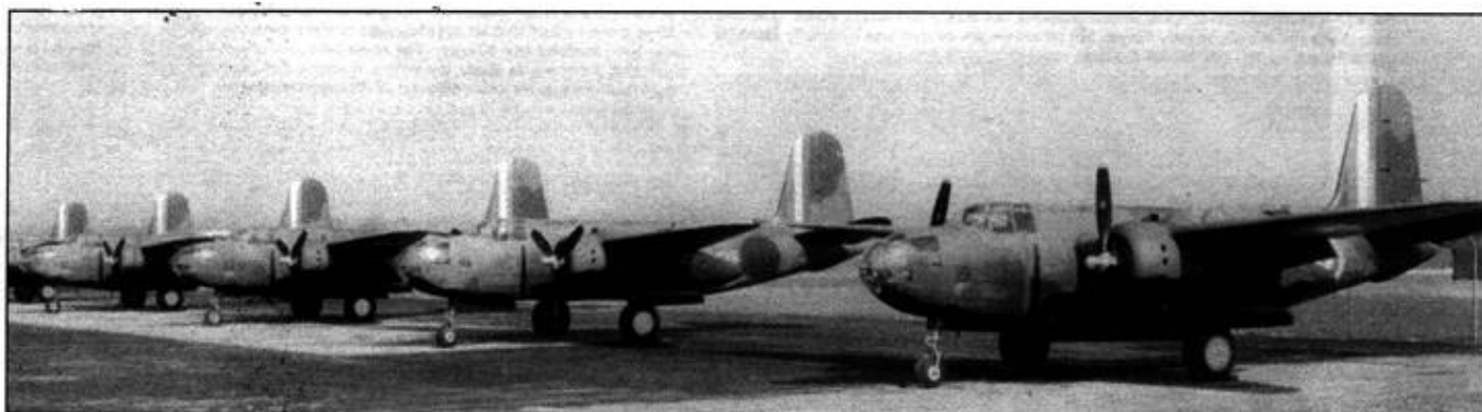
DB-7A отличался от DB-7 более мощными 1600-сильными двигателями «Райт R-2600-A5B». Внешне самолет можно было отличить по более длинным мотогондолам и более высокому килю. Эти самолеты выпущены для Франции, но достались Великобритании.
