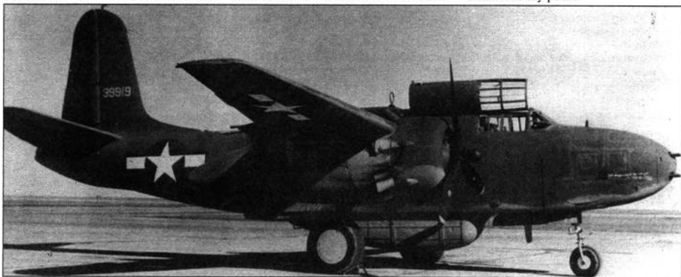
Самолет А-20G мог нести дополнительный топливный бак, который крепился под бомбовый отсек. Такой бак использовался при перегоне самолетов на дальние дистанции. При этом использовать бомбовый отсек по назначению было невозможно.
