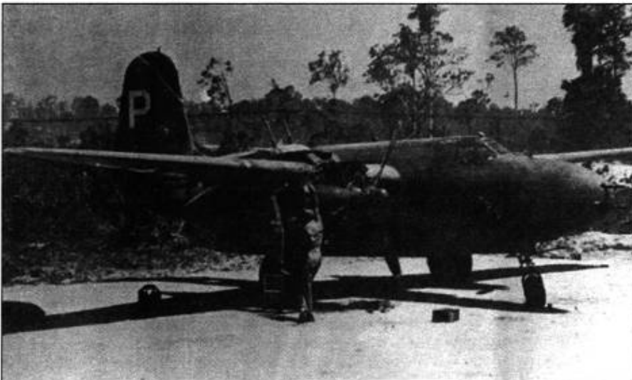
Механики ремонтируют двигатель А-20G из 417-й бомбардировочной группы. Эскадрильи в составе группы обозначались цветной полосой на киле.
