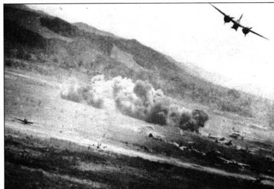
Каждая направляющая содержит одну 4,5-дюймовую ракету М3Т30. Ракеты имели фугасную боеголовку и стабилизировались в полете за счет вращения. А-20 мог нести двенадцать ракет. Опыт показал низкую эффективность этого оружия.
