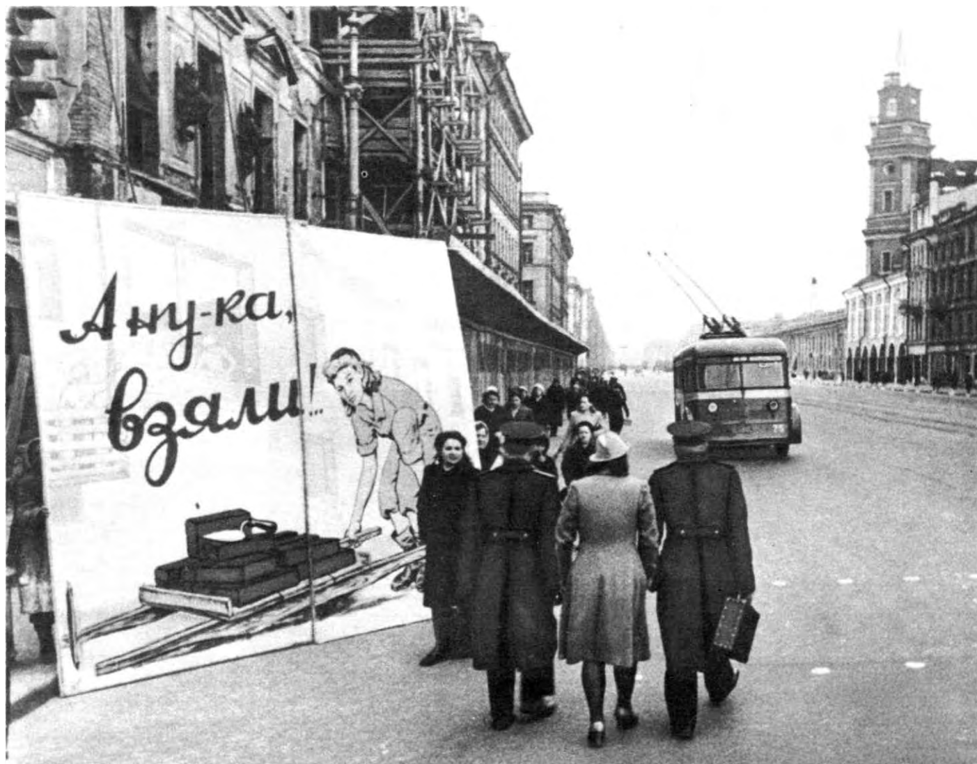
Ленинград, Невский проспект. Фото. 1943.
