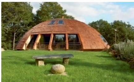
Еще один сферический экодом из дерева с изоляцией из пробки был разработан французским инженером Патриком Марсилли. Здесь, как и в доме из Коннектикута, тоже есть поворотный механизм. Но установлен он с другой целью: вращение максимально увеличивает количество света в затененных местах. Проще говоря, хозяин может поворачивать дом вслед за движением солнца, чтобы внутрь и на солнечные батареи на крыше попадало как можно больше света.
