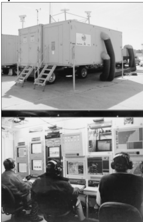
Рис. 3. Стационарный ПУ (вверху); операторы на рабочих местах
