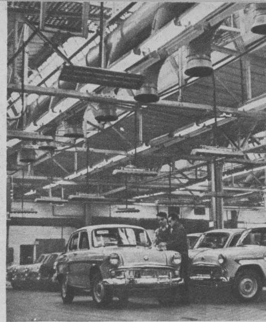
В отделочном цехе Московского завода малолитражных автомобилей воздух всегда свежий и чистый. Здесь работает мощная вентиляционная установка
