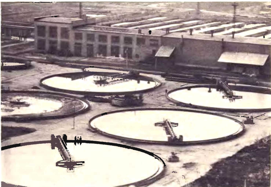
Станция биологической очистки промышленных стоков на Котласском целлюлозно-бумажном комбинате — крупнейшая в отрасли. Сотрудники Центрального научно-исследовательского института бумаги проводят здесь апробацию новых методов очистки воды.
