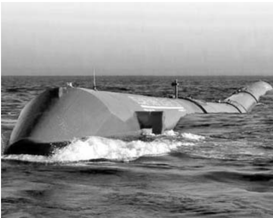
Волновая электростанция в Португалии
