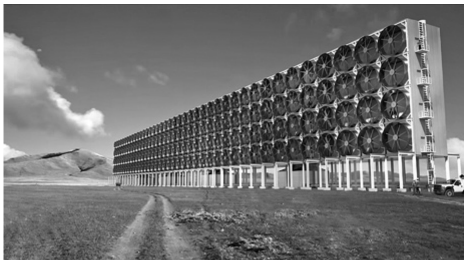
Установка для поглощения углекислого газа, Канада
