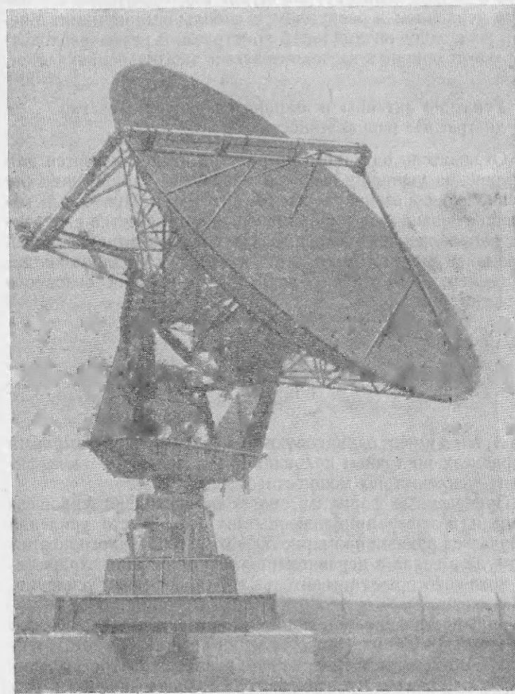
Фиг. 2. Обычная управляемая параболическая антенна (видна волноводная система).
